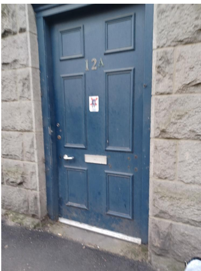
4. Existing door no. 3
