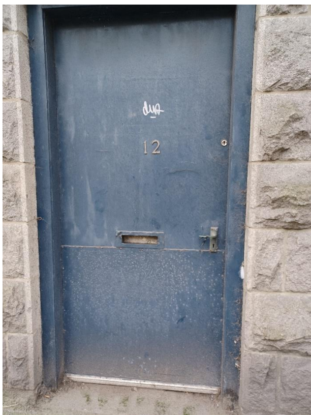
3. Existing door no. 2
